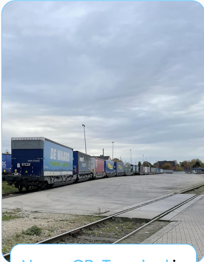
Neues CB-Terminal in Kaldenkirchen (DE)
